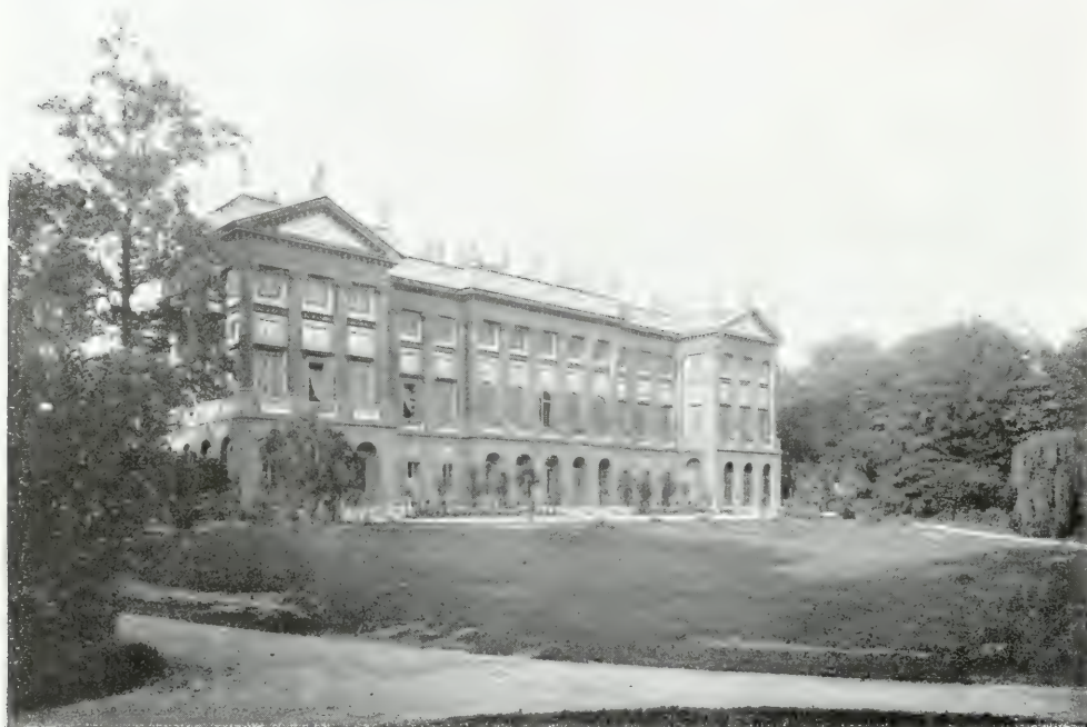
VILLA REALE, GIA BELGIOIOSO, VERSO IL GIARDINO, DELL'ARCH. L. POLLACK (A. 1790).
